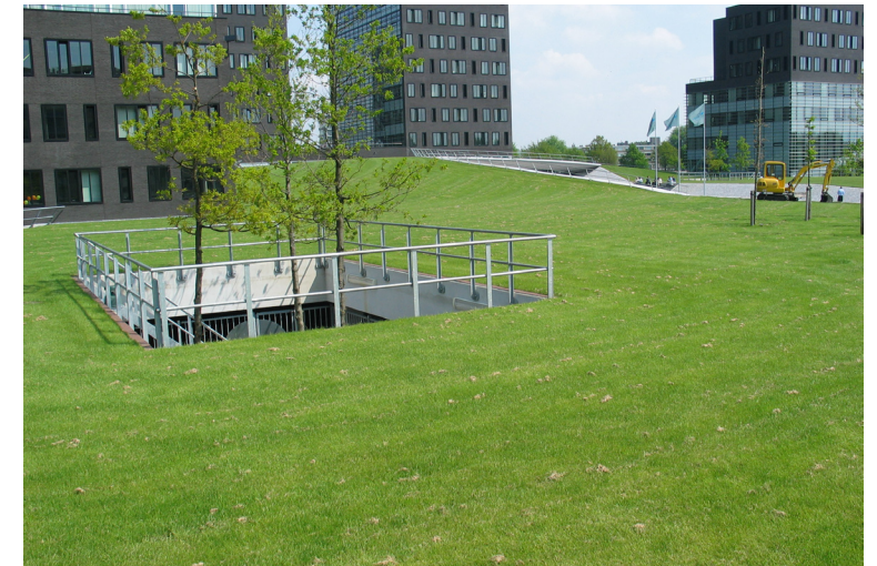
half verdiepte parkeergarage
