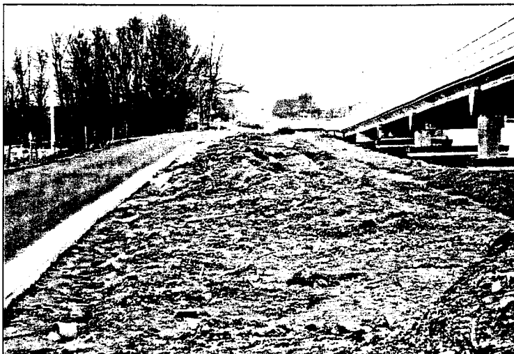
Figuur 2 - Kandelaarweg; Kandelaarbrug
