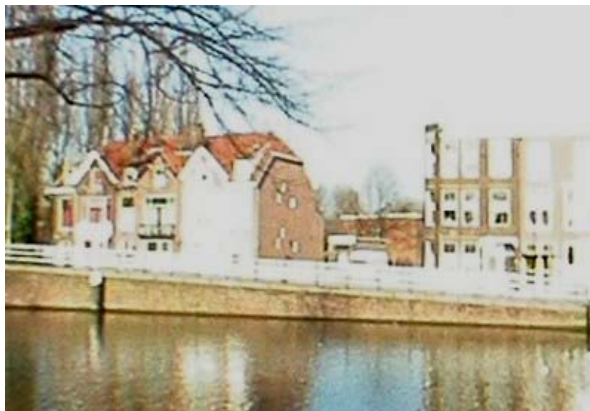
Huidig zicht vanaf de Oranje Plantage ter hoogte van de Donkerstraat in de richting van De Genestetstraat
