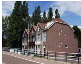
3 woningen aan de Oostsingel
