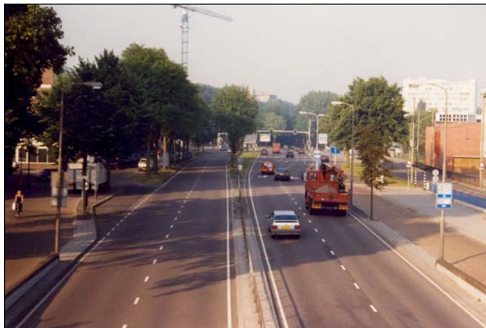
figuur 12: Westlandseweg t.p.v. Irenetunnel (huidige situatie)
