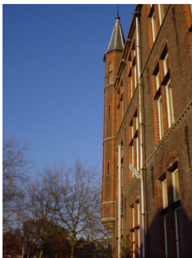
Figuur 3: Voorbeeld gevel TU-gebouw
