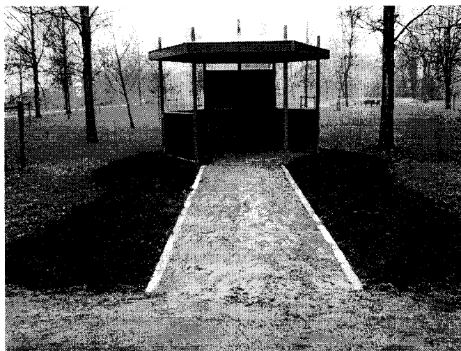
Aanleg JOP in Hof van Delftpark
