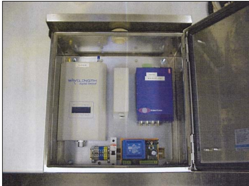
Figuur 3.7: Voorbeeld inrichting apparatuurkast voor draadloos cameratoezicht
