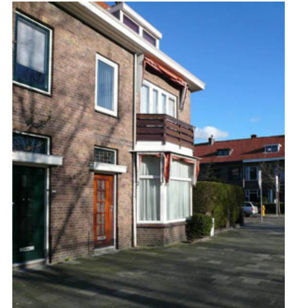
Erker 1 laag met balkon: Adriaan Pauwstr.
